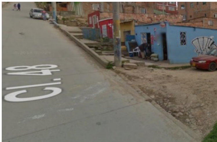
e. Las vías de conexión laterales a las viviendas no tienen tratamiento, son vías en tierra. Se aprecia que se acentúa la pendiente de la vía.
