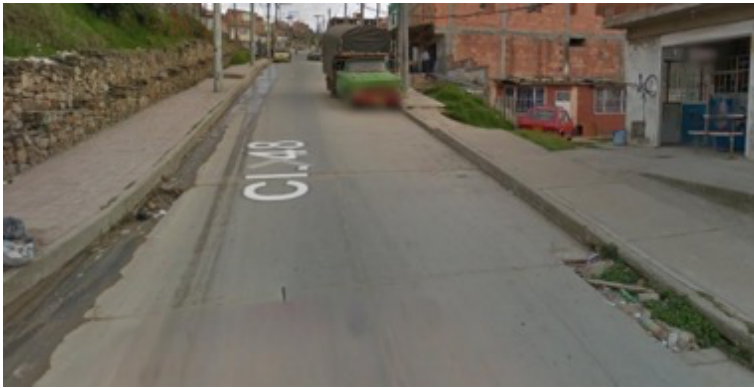
d. Metros más adelante por la calle 48 el pavimento rígido se aprecia en buenas condiciones. Sigue observándose una pendiente relativamente alta en el trazado. Hay andén a ambos costados y se aprecia sumidero.
