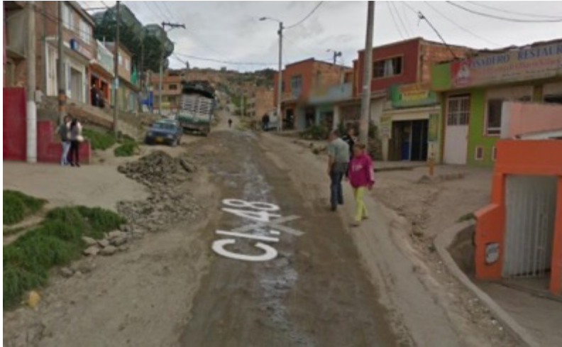
g. Los primeros tramos viales al interior del sector no tienen tratamiento y los andenes están seccionados por predios. No se aprecian obras para manejo de escorrentía.
