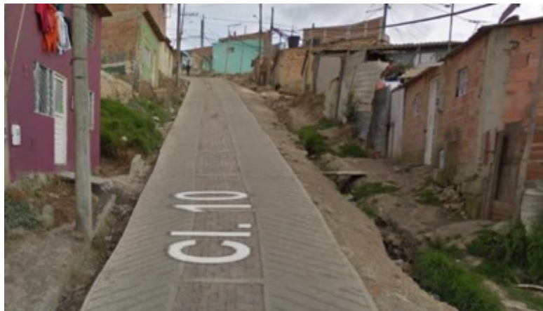
i. Culminando el trazado principal que atraviesa el asentamiento, se tiene un tramo con tratamiento en placa huella, pero no supera los 400m y no presenta andenes. La pendiente ascendente se mantiene. La escorrentía se maneja por cárcavas.
