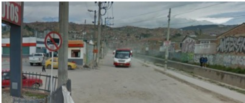
b. Tramo inicial sin tratamiento en la carpeta. Presencia de transporte público. En el fondo de la imagen se aprecian los cerros donde se ubica el asentamiento.
